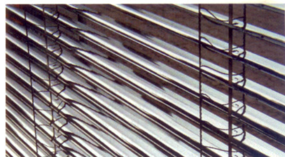
Einen Problemfall in der Reinigung stellen Tageslichtlenktechnik-Jalousien (TLT-Jalousien) dar, denn die Beschichtung ist anfällig für Kratzer und kann bei falscher Behandlung regelrecht „abblättern“
