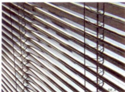
Nur saubere Tageslichtlenktechnik-Jalousien können ihre Funktion zuverlässig erfüllen.
