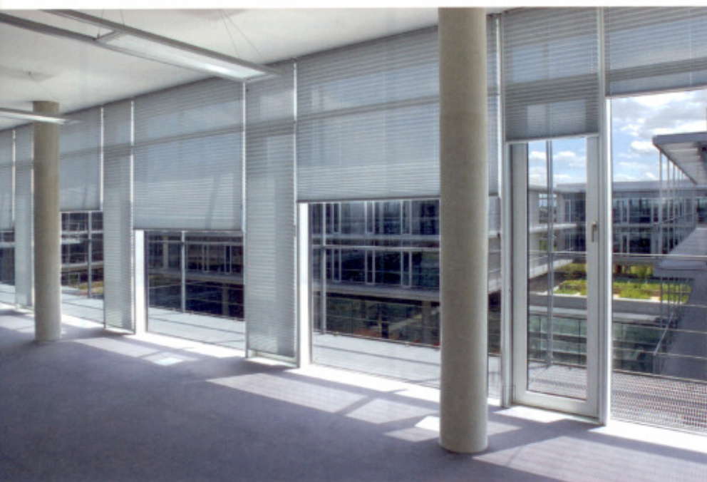
Spezielle Beschichtungen auf modernen Sonnenschutzanlagen, die für gute Reflexions-, Transmissions- und Absorptionswerte sorgen sollen, machen die Reinigung zur echten Herausforderung.
