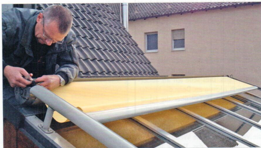
Nach der Reinigung montiert der Fachbetrieb die Wintergartenmarkise wieder. Foto: VDS
