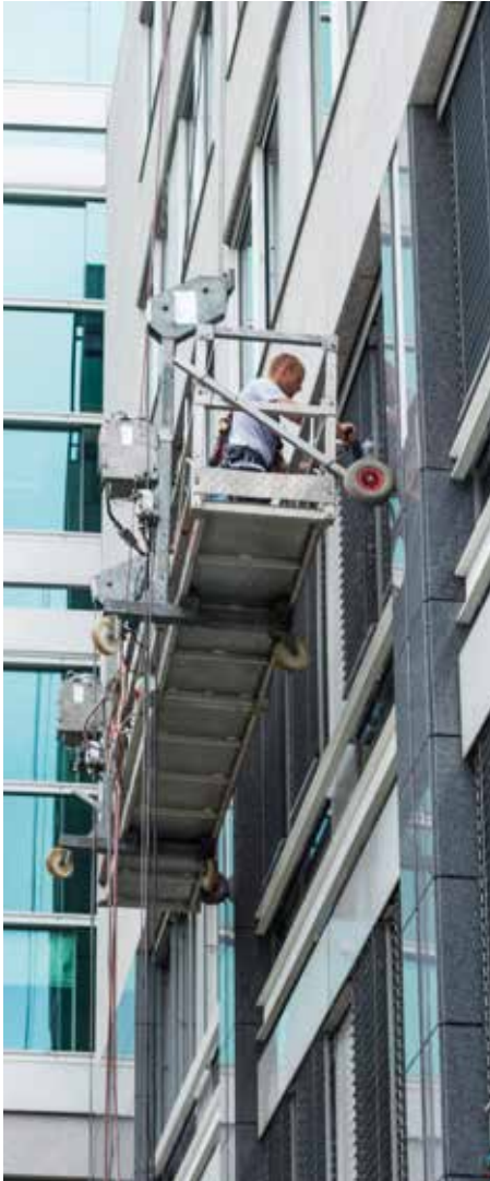
Aufgrund der Gegebenheiten vor Ort musste mit mobilen Fassadenbefahrnanlagen gearbeitet werden.
